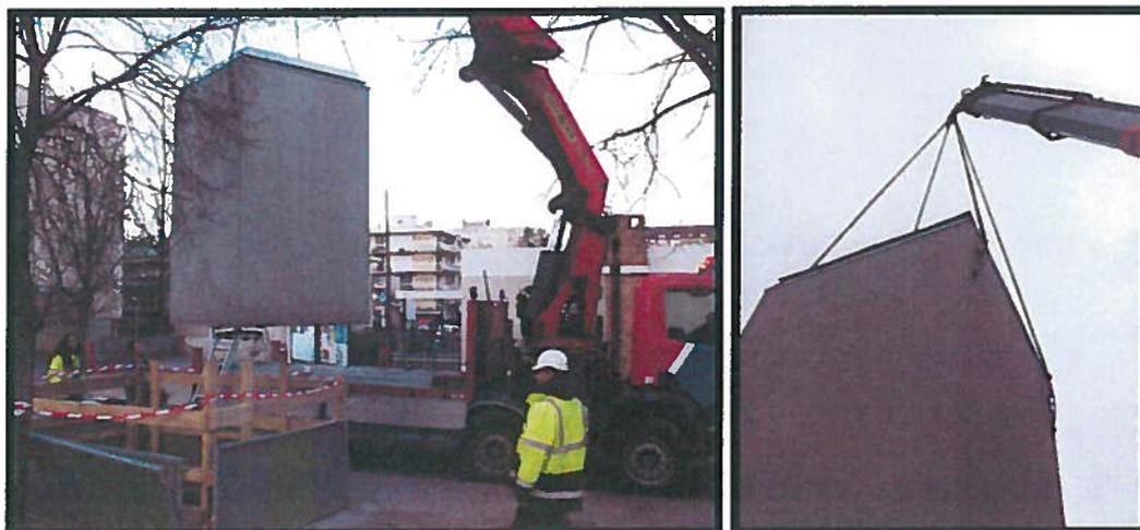
Utilisation d'un engin de levage d'une capacité mini de 7 tonnes à 5m
